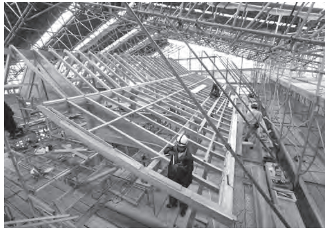
垂木を取り付けるなどの屋根下地作業(西脇殿)
